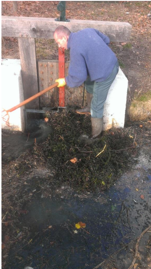
Nettoyages des vannes et déversoirs
